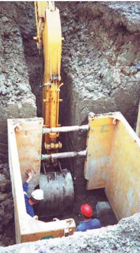
Le caisson regard est toujours utilisé si des puits plus larges doivent être installés dans une tranchée courante. Le corps des panneaux est en forme de U et remonte sur 0,40 m de chaque côté de la tranchée. On obtient ainsi une zone de travail plus large de 0,80 m.
